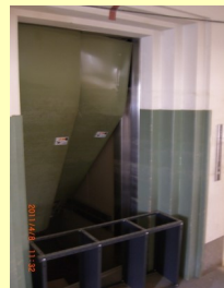
壁に残る爪痕、折曲がったエレベーターのドア
